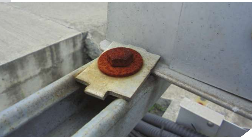
Fig. 1. Corrosión galvánica
