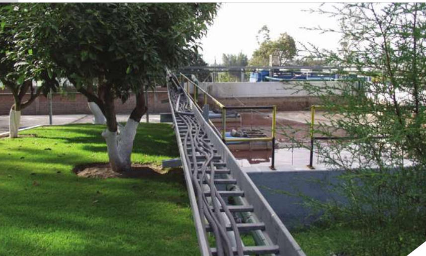
Fig. 6. Aplicaciones de galvanizado en caliente por inmersión
